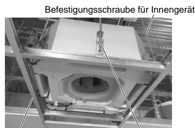
Befestigungsschraube für Innengerät Rasterdecke Befestigungsschraube für Rasterdecke
