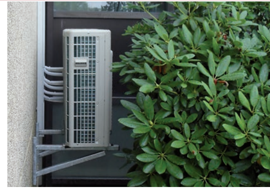
Wandinstallation einer RAM-70, die bis zu 4 Inneneinheiten versorgen kann
